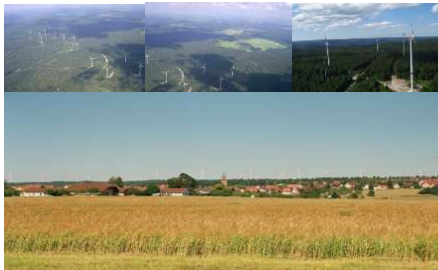
Abbildung 2: Ansichten: Windpark Simmersfeld (Quelle: Kurt Seeger, aufgenommen 2007)
