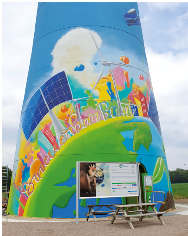
Bürgerwindanlage mit Ausstellung und Graffiti im Bürgerwindpark A31 Hohe Mark (Foto: Bredemann)
