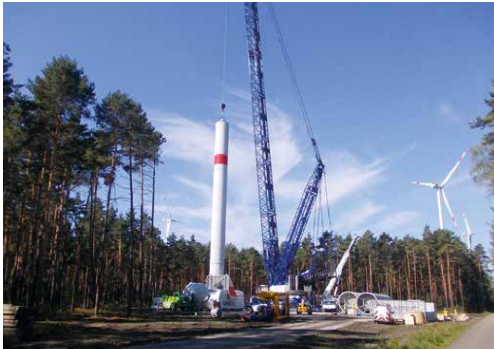
Aufbau einer Windenergieanlage in Südbrandenburg, © PNE
