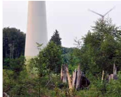
Windenergieanlage auf Windwurffläche, © Landesforsten.RLP.de/Lamour/Hansen
