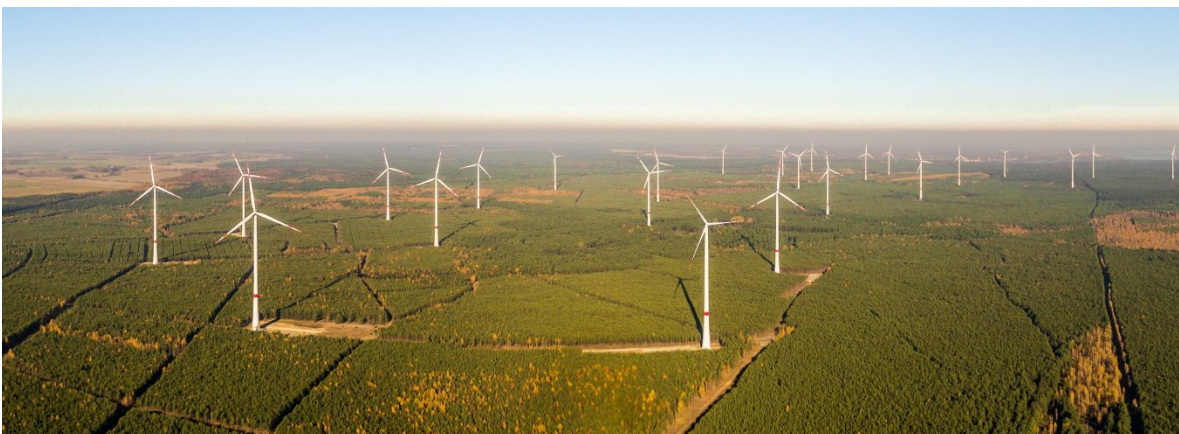
Abbildung 19: Windpark Chransdorf West im Landkreis Oberspreewald-Lausitz (Brandenburg)
