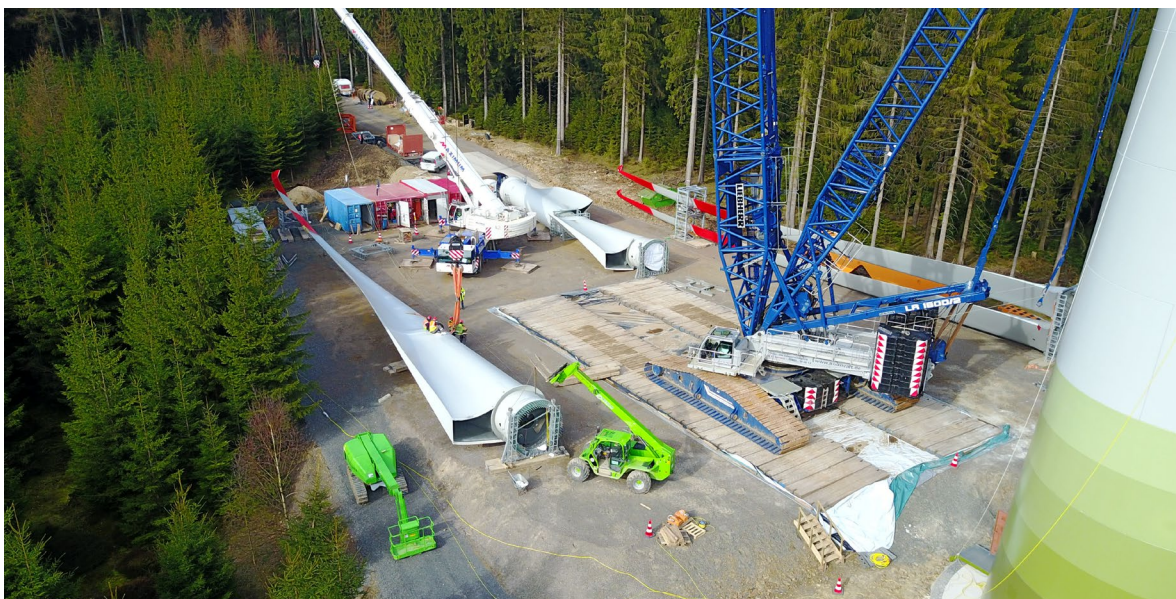
Abbildung 6: Kranstellfläche und temporäre Montageflächen während des Aufbaus einer Windenergieanlage
