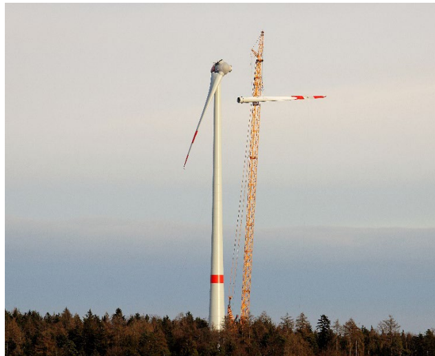
Abbildung 15: Anlagenerrichtung im Windpark Brenntenberg, Landkreis Regensburg (Bayern)
