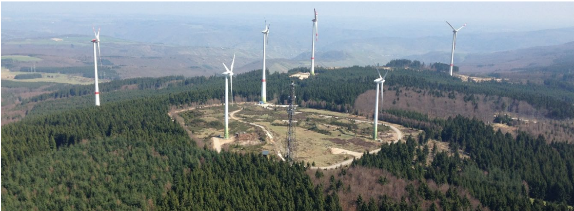
Abbildung 30: Windpark Kandrich auf ehemals militärisch genutztem Standort im Landkreis Bad Kreuznach (Rheinland-Pfalz)
